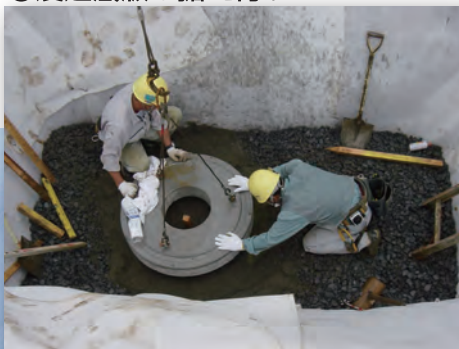
⑤浸透直壁の据え付け
